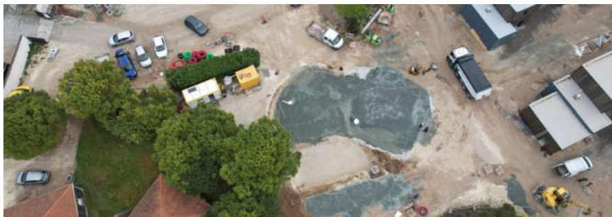
Organisation des travaux et gestion des déchets à Côté Océan
