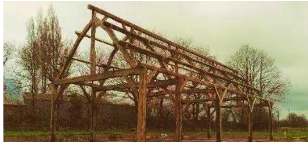
Construction d'un hangar low-tech
